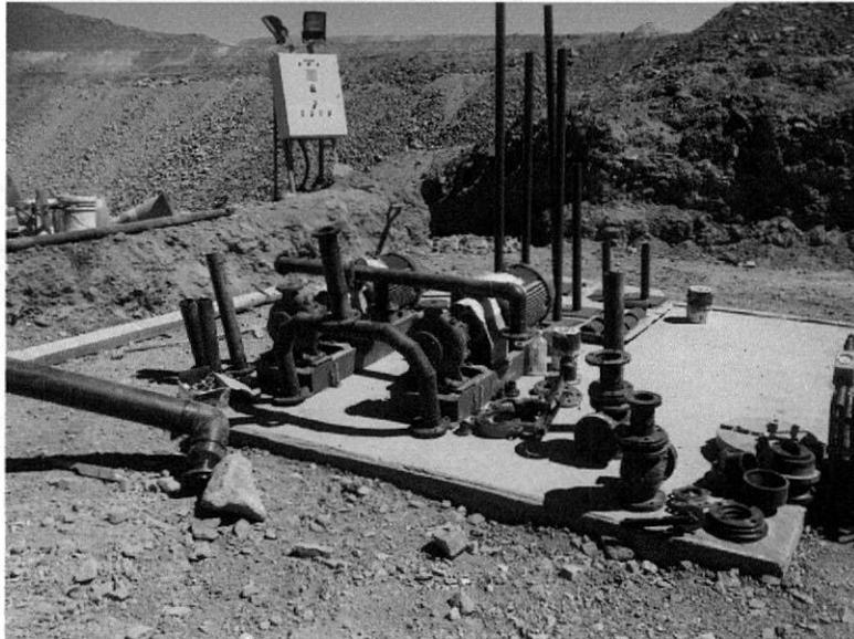
**Fotografía 1:** Materiales recepcionados en terreno y bombas sobre losa.
