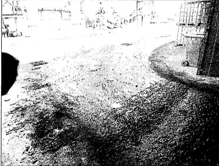
Ilustración 5: Piso con derrames de ácido y grúas horquilla.
