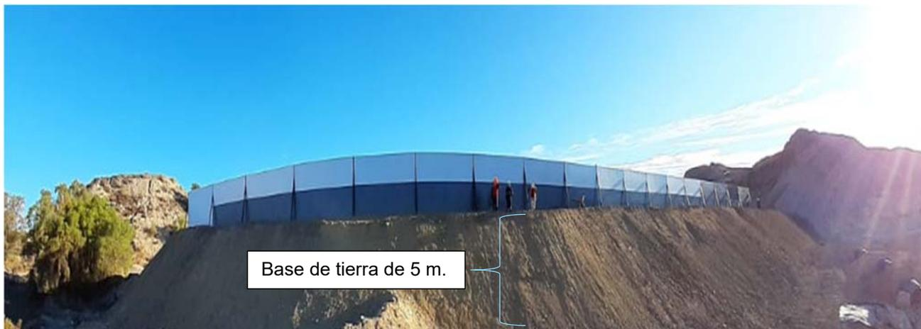
**Figura 2.** *Ubicación de base de tierra en construcción de barrera acústica sector norte rajo CDA.*
