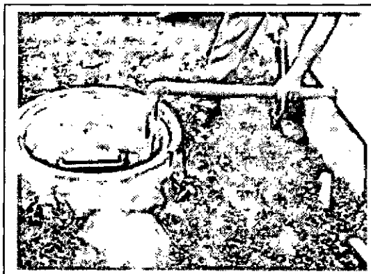
Imágenes 3 y 4: El ducto de PVC fue cortado con sierra manual, eliminando así toda posibilidad de que algún residuo descargue hacia la cámara.
