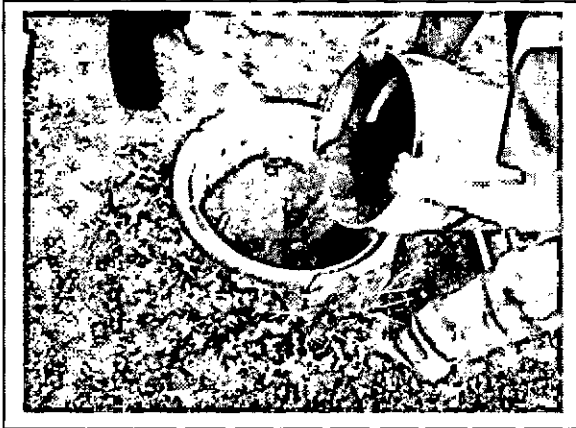
Imágenes 5 y 6: Luego, la cámara vacía fue rellena con tierra hasta 10 cms bajo el borde superior, en el espacio restante se cubrió por una capa de ripio y piedras.
