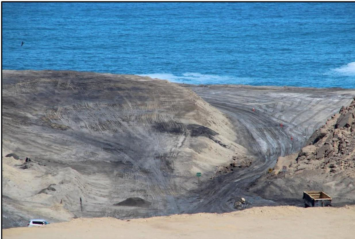
En la fotografía se pueden apreciar las operaciones de compactación de las cenizas con áridos, además de las maniobras de humectación.
