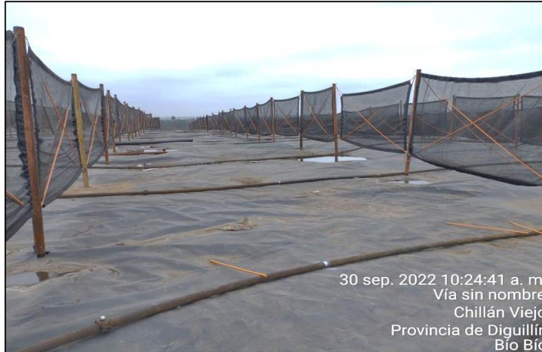
**Figura 1.** Sistema de evaporación natural asistida
