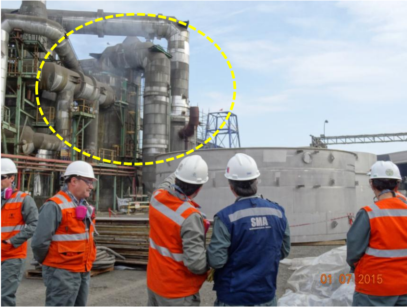
Fotografía 71. Fecha: 01 de julio de 2015 Coordenadas DATUM WG84 HUSO 19 Este : 267.651 m Norte: 6.372.431 m Descripción medio de prueba: Evidencia de emisión de gases fugitivos desde la Planta de Ácido por rotura en cámara superior de intercambiador de gas.
