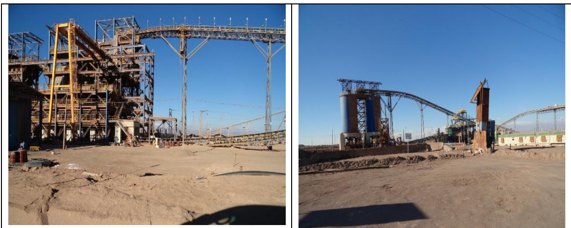
Planta de Chancado y Clasificación, planta denominada "El Toco".
