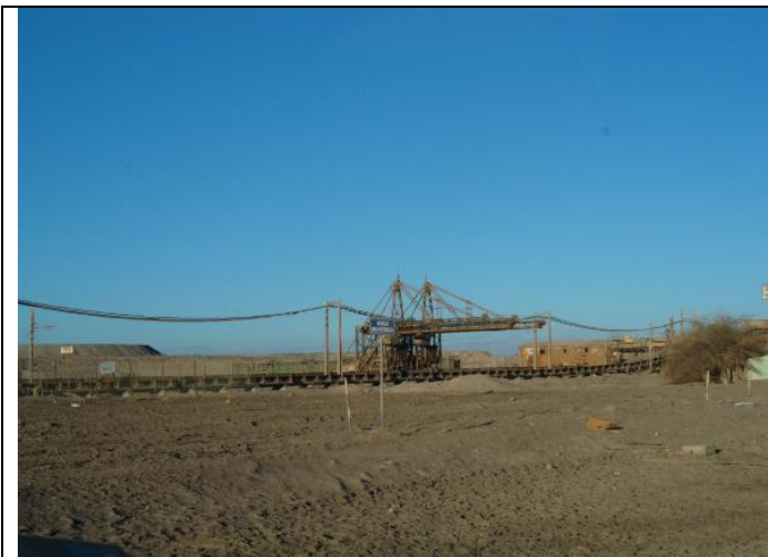
Sitio en el que se ubicaban rieles del ferrocarril que transportaba caliche.
