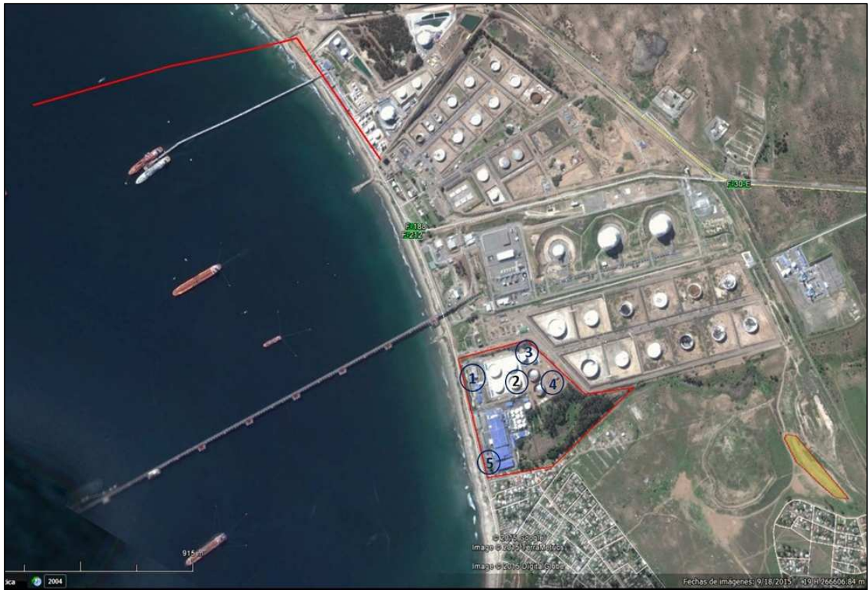
Figura 3. Detalle recorrido durante inspección ambiental.
