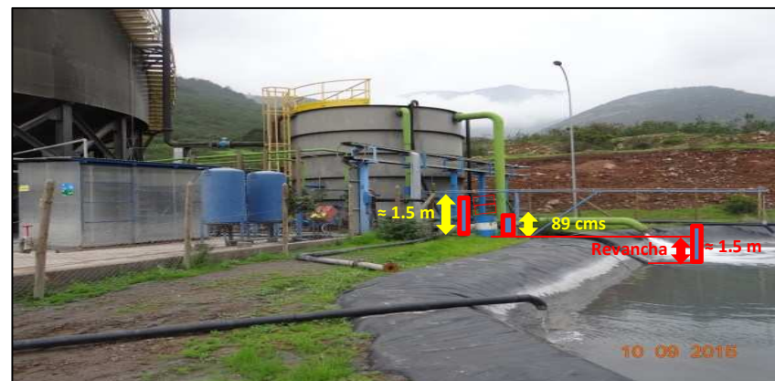
Fotografía 8. Fecha : 10 de Septiembre de 2015 Coordenadas DATUM WGS84, Huso 19 Este: 304.761 m. Norte: 6.404.652 m. Descripción Medio de Prueba: Piscina impermeabilizada con geomembrana. Se visualiza que el nivel de su revancha es menor a 1,5 m.
