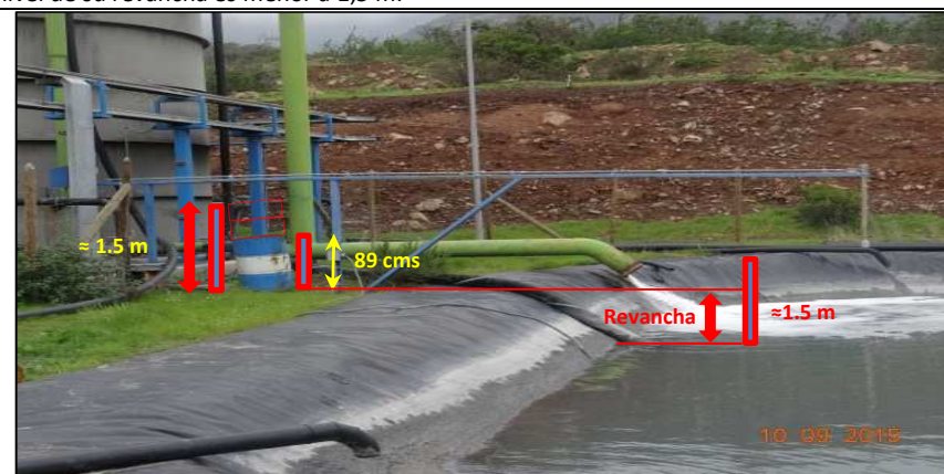
Fotografía 8. Fecha : 10 de Septiembre de 2015 Coordenadas DATUM WGS84, Huso 19 Este: 304.761 m. Norte: 6.404.652 m. Descripción Medio de Prueba: Piscina impermeabilizada con geomembrana. Se visualiza que el nivel de su revancha es menor a 1,5 m.
