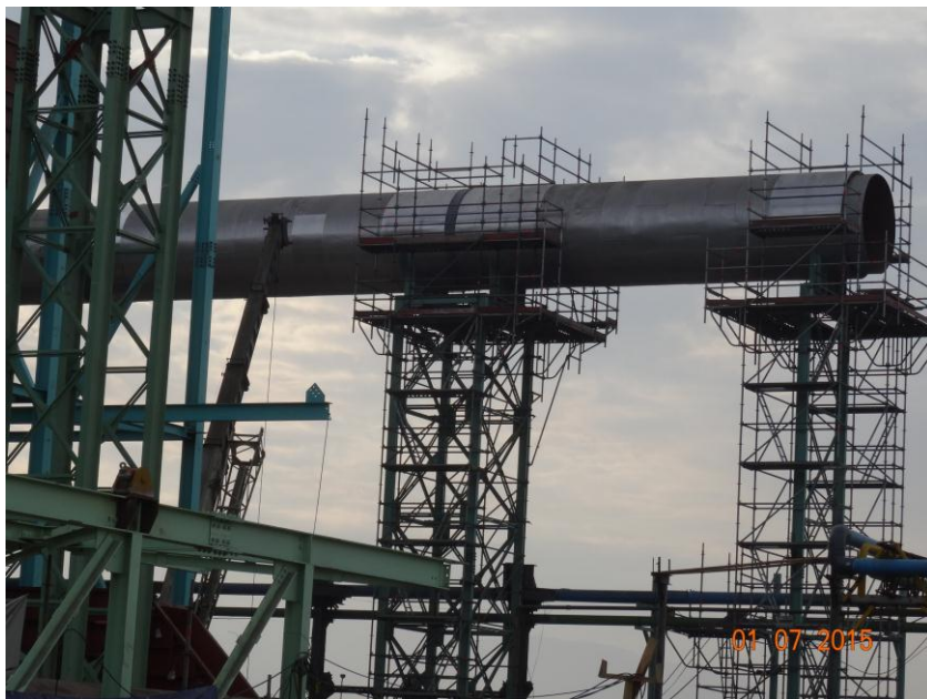
Fotografía 65. Fecha: 01 de julio de 2015 Coordenadas DATUM WG84 HUSO 19 Este : 267.505 m Norte: 6.372.274 m Descripción medio de prueba: Evidencia de instalación y montaje de ducto para conectar con chimenea principal.
