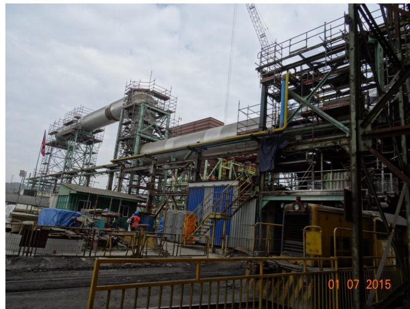
Fotografía 66. Fecha: 01 de julio de 2015 Coordenadas DATUM WG84 HUSO 19 Este : 267.505 m Norte: 6.372.274 m Descripción medio de prueba: Evidencia de instalación y montaje de ducto para conectar con chimenea principal.
