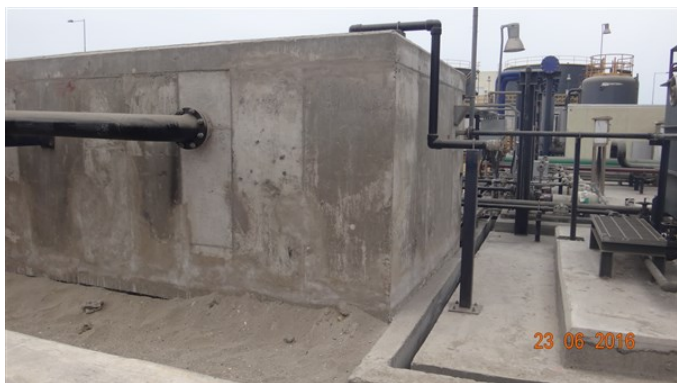
Fotografía 3. Fecha: 23 de junio de 2016 Coordenadas UTM Datum WGS84 Huso 19 Norte: 7.448.732 Este: 359.972 Descripción medio de prueba: Estanque separador de agua/aceite.
