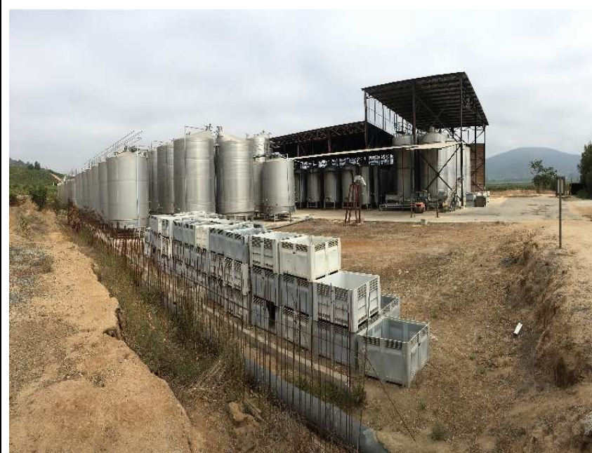
Fotografía 9. Fecha : 23 de Marzo de 2017 Coordenadas DATUM WGS84, Huso 19 Este: 285.919 m. Norte: 6.311.704 m. Descripción Medio de Prueba: Vista Nor-orienté de la zona de estanques de bodega de vinos. Se aprecia su inactividad.
