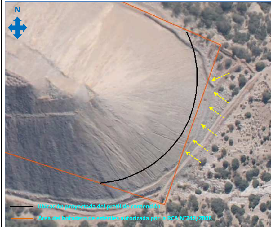
Figura 39. Fecha imagen: 29 de abril de 2017. Descripción medio de prueba: En la imagen se aprecia el área autorizada para el botadero y al interior de ella la disposición proyectada del pretil de contención que no fue ejecutada acorde al plano MC-04 del Adenda 3. Además, en flechas color amarillo se indica el pretil de contención constatado en terreno fuera del área autorizada, al pie del botadero de estériles. Fuente: Elaboración propia en base a imagen aérea y planimetría requerida a EXPLODESA.
