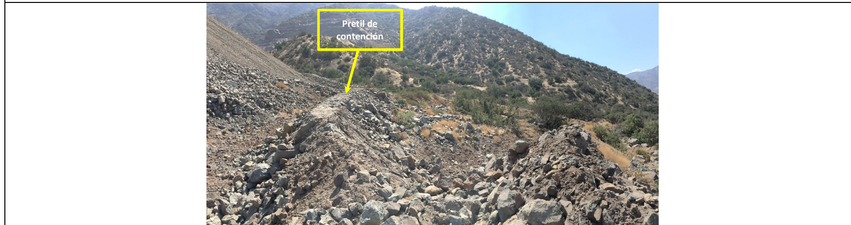
Fotografía 42. Fecha: 29 de marzo de 2017 Coordenadas WGS84, Huso 19 Norte: 6.382.138 m. Este: 315.200 m. Descripción medio de prueba: Evidencia de presencia de rocas al pie del botadero de estériles, por sobre el área del mismo autorizada por la RCA N°242/2008 y el pretil de contención, interviniendo sector con vegetación nativa que representa hábitat de Lithrea caustica (Litre) y Acacia caven (Espino), así como de plantas herbáceas silvestres.
