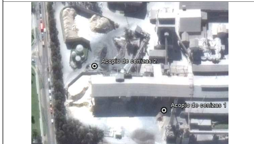
Figura 8. Coordenadas (Acopio Cenizas 1) Norte: 6.369.781 m. Este: 294.047 m Coordenadas (Acopio Cenizas 2) Norte: 6.369.875 m. Este: 294.026 m
