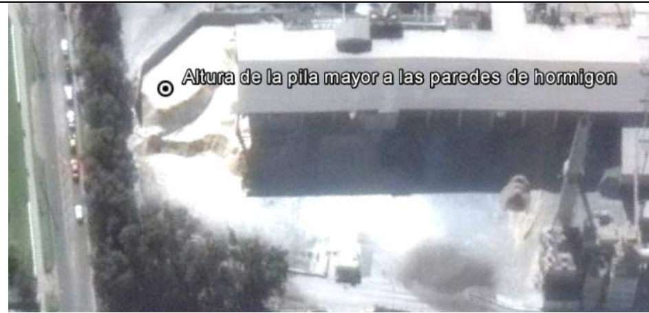
Figura 15 Coordenadas WGS84, Huso 19 Norte: 6.369.872 m. Este: 293.988 m Descripción medio de prueba: En la imagen aérea se aprecia el sector en donde se constató que la altura de la pila de la conchuela almacenada excede la altura de las paredes de hormigón. Fuente: Imagen Google Earth del 17 de agosto de 2016.
