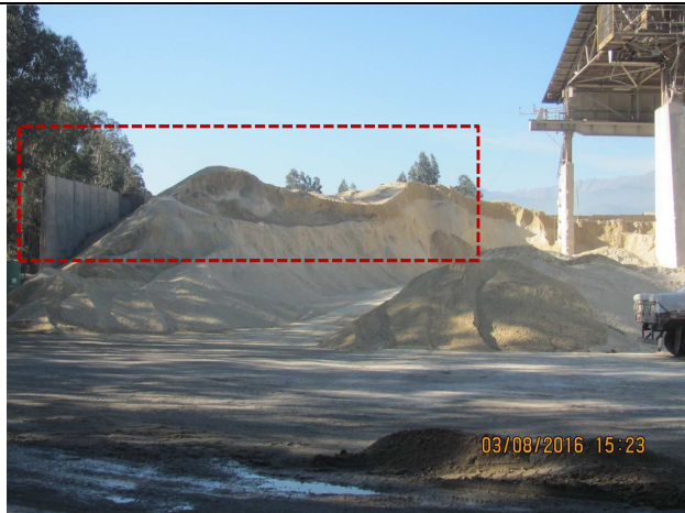
Fotografía 7 Fecha: 3 de agosto de 2016 Coordenadas WGS84, Huso 19 Norte: 6.369.872 m. Este: 293.988 m Descripción medio de prueba: En la imagen se aprecia que la altura de la pila de la conchuela almacenada excede la altura de las paredes de hormigón, en área no techada del sector norte cancha nave grúas puente.
