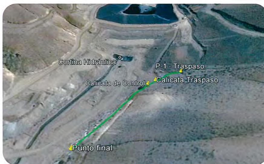
Figura N° 1 Área involucrada en el evento Figura N°1: Extensión del derrame según lo informado por el titular.
