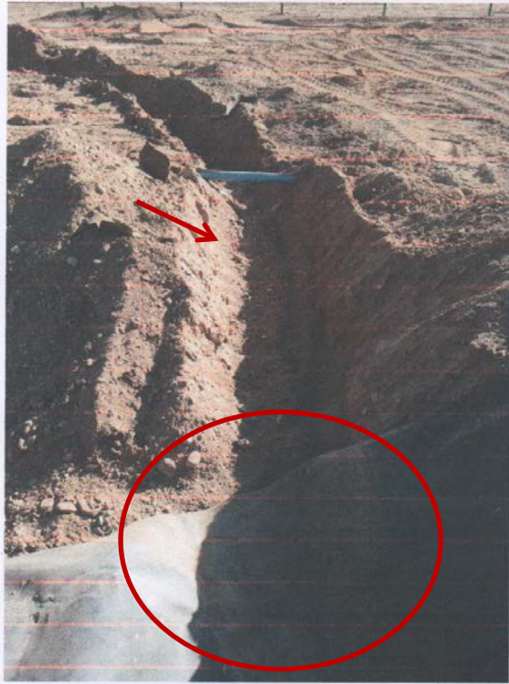
1.-Salida de canal interceptor de aguas lluvia en Celda con fondo revestido en HDPE.
