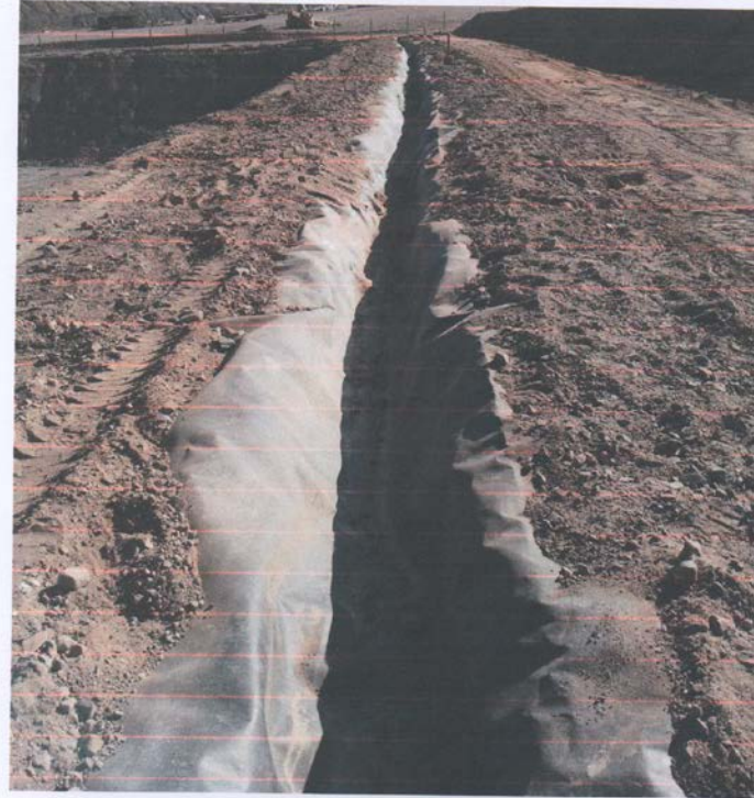
2.-Canal interceptor de aguas lluvia en Celda con fondo revestido en HDPE.
