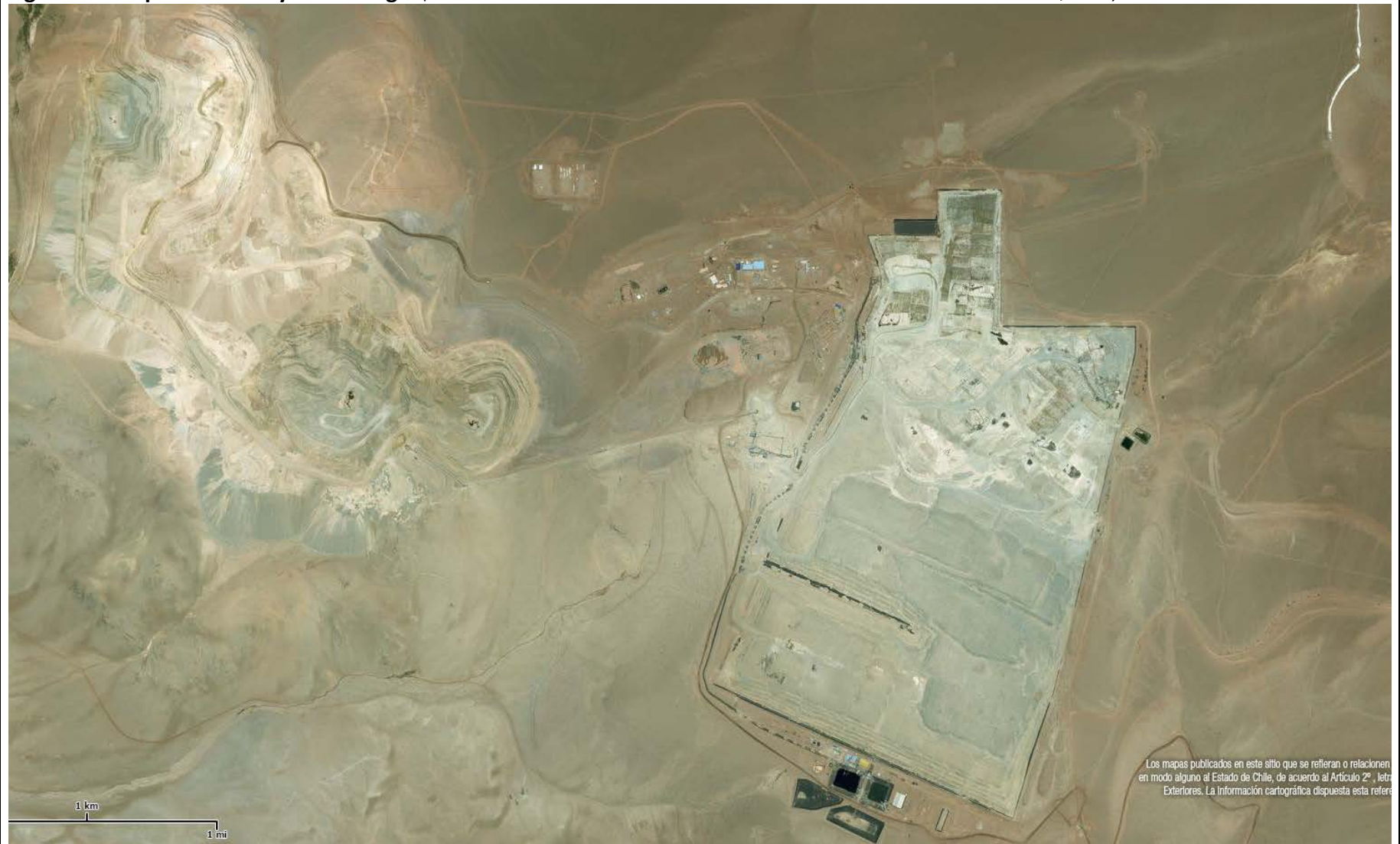
Figura 2. Campamento Proyecto Refugio (Fuente: Herramienta Análisis Territorial del Servicio de Evaluación Ambiental, 2017).
