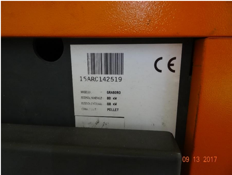
Fotografía N°2 Fecha: 13/09/2017. Descripción: En la fotografía se aprecia el modelo de la caldera y la potencia nominal de la misma.
