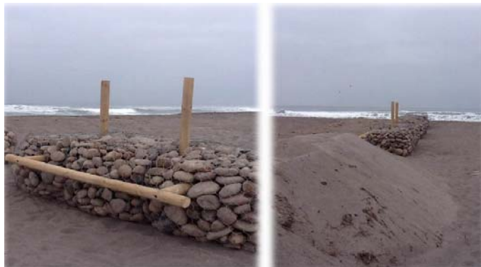
Fotografía 5. Fuente: ORD. N° 2072 de fecha 17 de abril de 2018 (Anexo 2).
