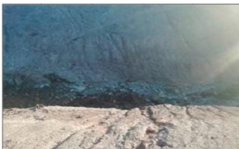
Imagen 11. Fondo de Quebrada después de la limpieza.
