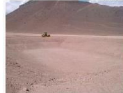
Figura 24- Imagen georreferenciada piscina compactada.
