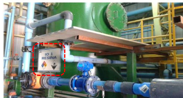
Figura 12 - Columna IO'1 con su tapa colocada.
