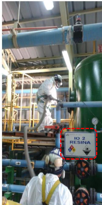
Figura 4 - Aspiración de resina del interior de la columna IO2
