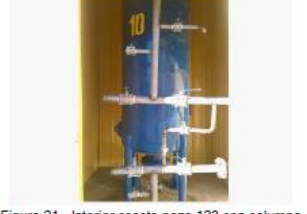
Figura 21 - Interior caseta pozo 123 con columna.
