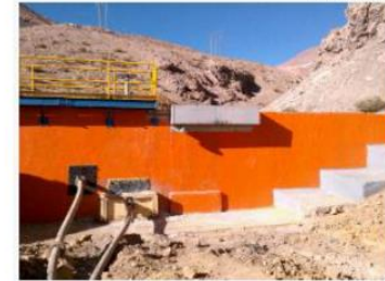
Figura 4.11: Registro georreferenciado muro rehabilitado con cajón.
