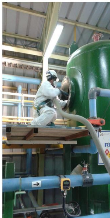
Figura 5 - Trabajo de aspiración de resina.
