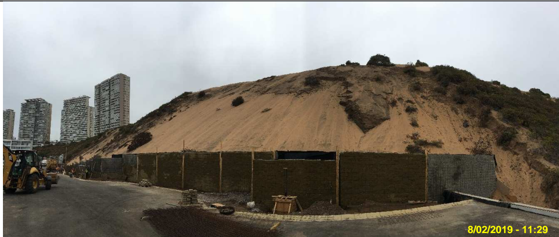
Fotografía N°2 Fecha: 8 de febrero de 2019. WGS84 Huso 19 Norte: 6.352.808 m. Este: 216.615 m. Descripción del medio de prueba: Vista de la construcción de la extensión de la calle Cornisa en el sector sur del proyecto de loteo y urbanización.
