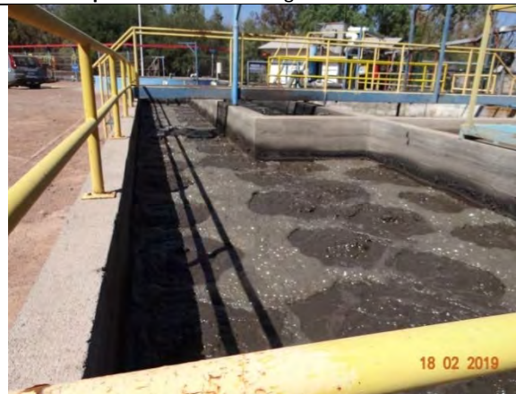
Fotografía 6 Fecha: 18-02-2019 Coordenadas UTM DATUM WGS84 HUSO 19 Norte: 7.464.604 Este: 583.033 Descripción del medio de prueba: Digestor, lugar de maduración de lodos.
