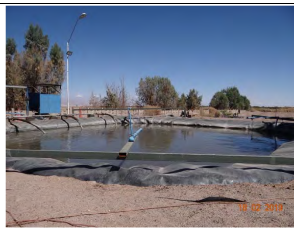
Fotografía 4 Fecha: 18-02-2019 Coordenadas UTM DATUM WGS84 HUSO 19 Norte: 7.464.586 Este: 583.046 Descripción del medio de prueba: Reactor Biológico 3.
