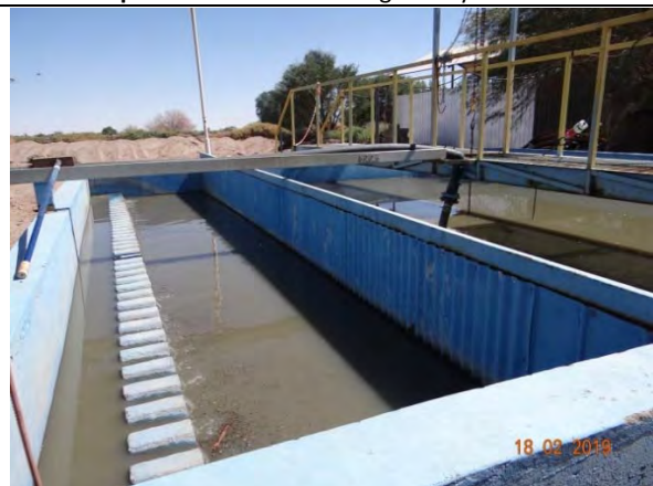
Fotografía 5 Fecha: 18-02-2019 Coordenadas UTM DATUM WGS84 HUSO 19 Norte: 7.464.584 Este: 583.040 Descripción del medio de prueba: Sedimentador, separación fases líquida y sólida.
