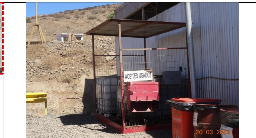
Fotografía 35. Fecha: 20-03-2019 Coordenadas UTM DATUM WGS84 HUSO 19S Norte: 6.763.470 Este: 298.997 Descripción del medio de prueba: Galpón de "Aceites usados", techado, cerrado con malla y base de hormigón, con 2 bins plásticos con aceites usados.
