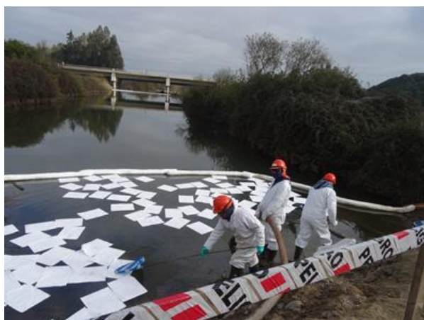
Fotografía N°3. Fecha: 24-07-18 Coordenadas DATUM WGS84 HUSO 19 S Este: 268.418 Norte: 6.364.633 Descripción de medio de prueba: Material absorbente dispuesto aguas abajo: del lugar del siniestro y pasado el puente Santa Julia.
