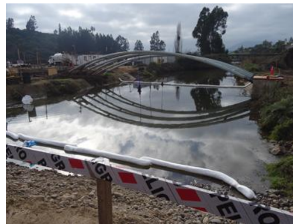
Fotografía N°2. Fecha: 24-07-18 Coordenadas DATUM WGS84 HUSO 19S Este: 268.418 Norte: 6.364.633 Descripción de medio de prueba: Material absorbente dispuesto en el lugar del siniestro y aguas arriba.
