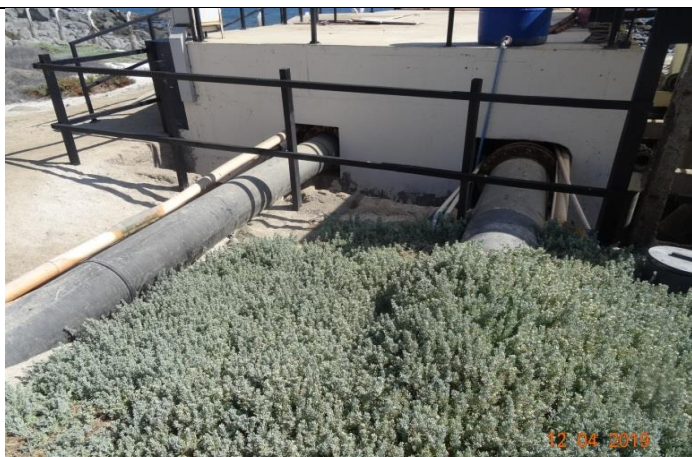
Fotografía 9. Fecha: 12-04-2019 Coordenadas UTM DATUM WGS84 HUSO 19 S Norte: 7.017.103 Este: 320.909 Descripción del medio de prueba: Tuberías de sistema de distribución de agua desde la sala de máquinas.
