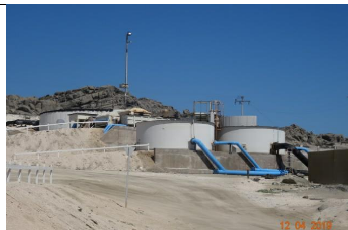
Fotografía 10. Fecha: 12-04-2019 Coordenadas UTM DATUM WGS84 HUSO 19S Norte: 7.017.014 Este: 320.977 Descripción del medio de prueba: Tuberías de sistema de distribución de agua de estanque de acumulación y distribución.
