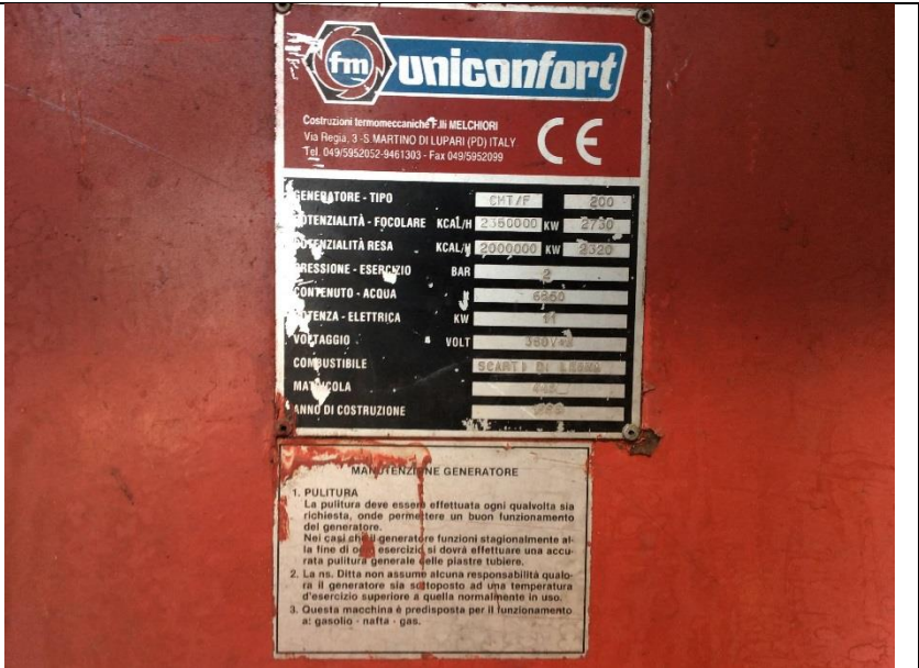
Fotografía N°2 Fecha: 19.11.2019 Descripción: Placa Caldera SPBIOBIO-271, la cual se encontró operando al momento de la inspección.
