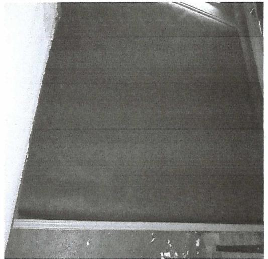
VISTA DESDE EL INTERIOR DEL LOCAL HACIA AFUERA CON BARRERA DE SONIDO INSTALADA PARA LA REDUCCION DE RUIDO Y ELIMINACION DE CONTACTO CON EL EXTERIOR PARA EVITAR EL FILTRADO DE RUIDO.
