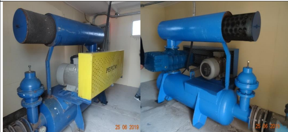
Fotografía 15. Fecha: 25-06-2019 Coordenadas UTM DATUM WGS84 HUSO 19 S Norte: 7.007.808 Este: 319.663 Descripción del medio de prueba: Interior de galpón con 2 aireadores (Blower).
