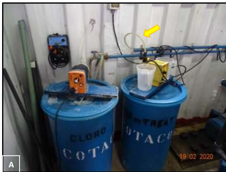
Fotografía 4. Administración Antiincrustante y Equipo Osmosis Inversa
