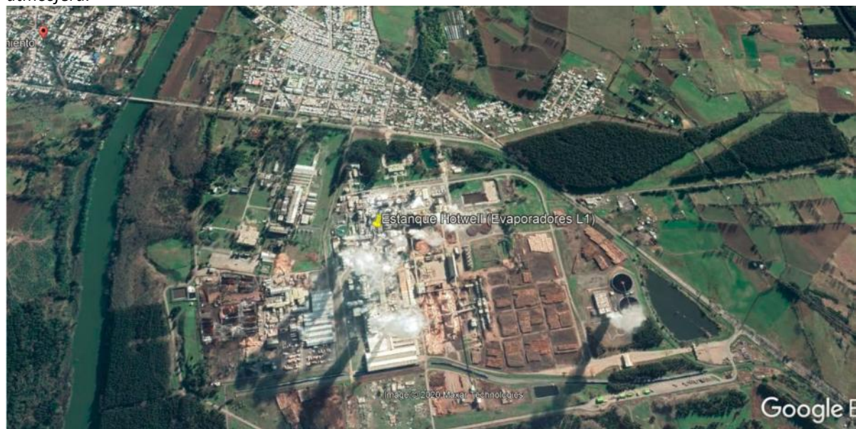
Figura 4: Ubicación geográfica del estanque de condensado sucio y su entorno
