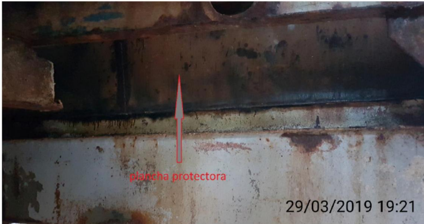
Fotografía N°1: reparación bandeja filtro rotatorio N°2
