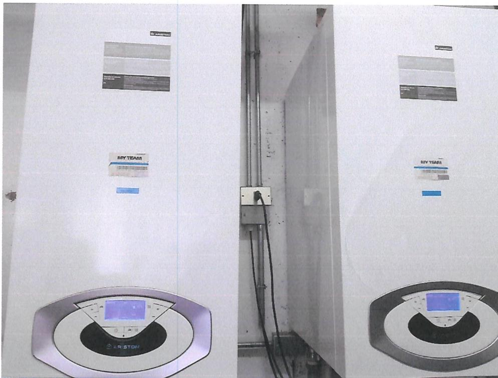
**Imagen 4.** Calderas a gas; uso: calefacción y generación de agua caliente
