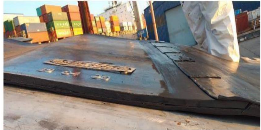
Set 6: Proceso de Empalme y Vulcanizado en Caliente con Planchas
