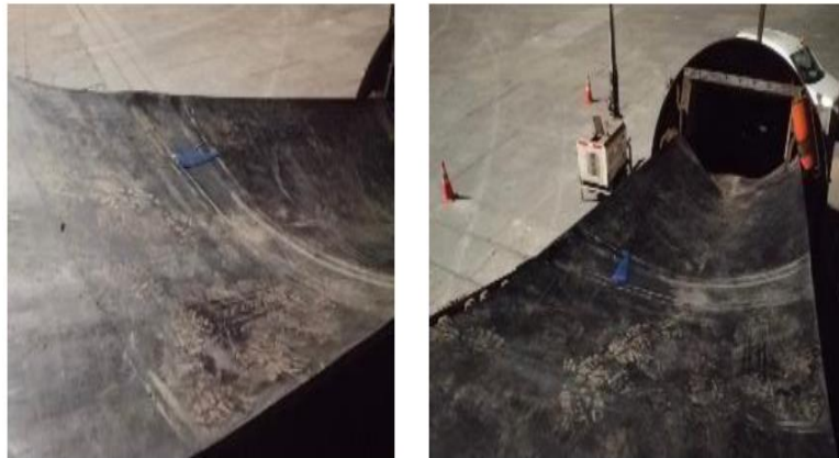
Set 7: Término de Instalación y empalme de Cinta
