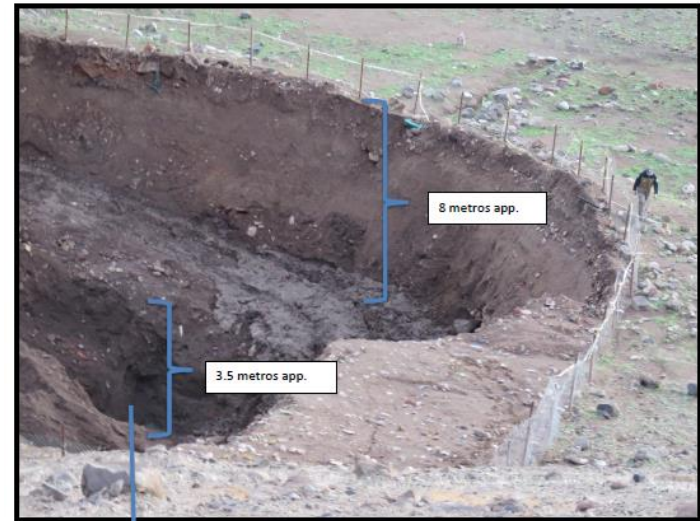
Imagen N° 7.- 20/05/2020. Napa de agua y subexcavación de 3.5 metros app.
