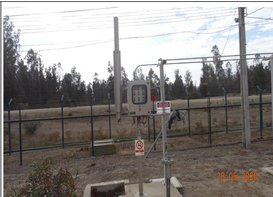
Fotografía 6. Fecha : 28 de Mayo de 2020 Coordenadas DATUM WGS84, Huso 19 Este: 275.958 m. Norte: 6.312.304 m. Descripción Medio de Prueba: Sistema de antorcha y panel de control del flujo de biogás que se quema en la antorcha.
