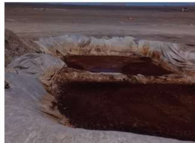
Fotografía 3: Membrana de polietileno instalada
