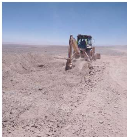
Fotografía 2: Construcción fosa plataforma B04
