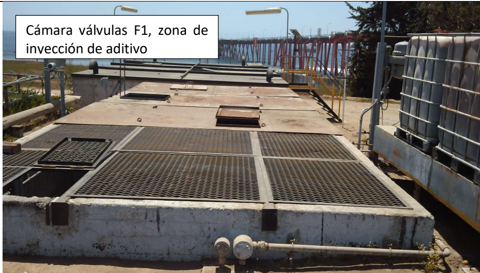
Figura N°3 detalle de cámara válvulas F1
