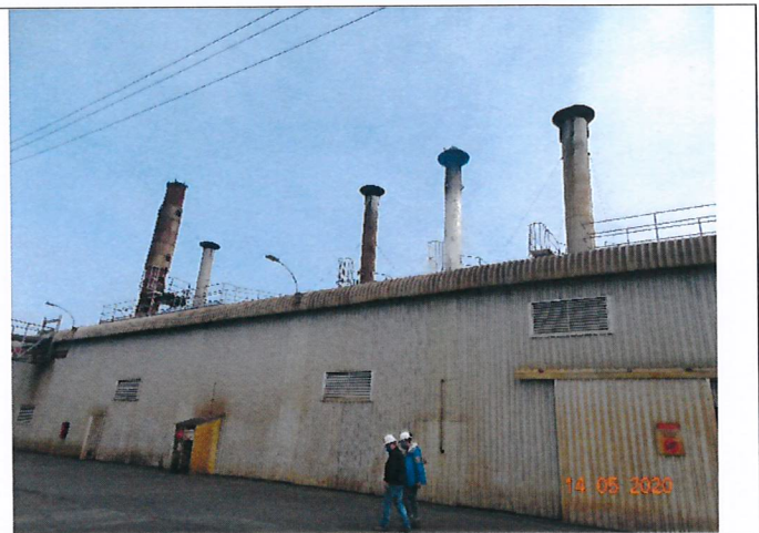
Fotografía 2: exterior sala de calderas, chimeneas.
