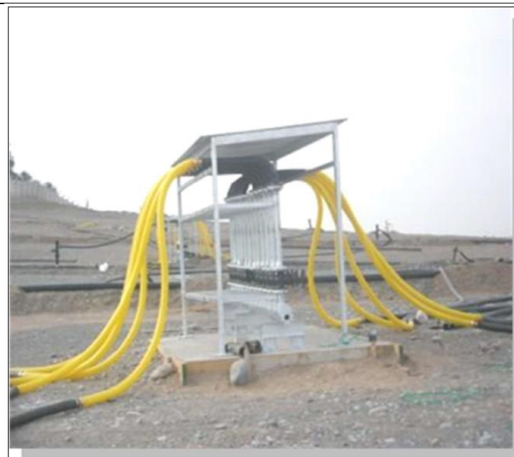
Ilustración 3. Caseta de Regulación en funcionamiento
