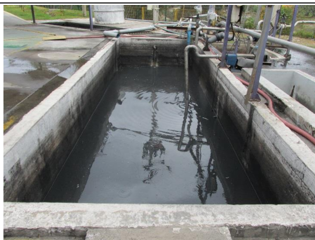
Fotografía 4. Pozo recepción agua tipo III y IV
