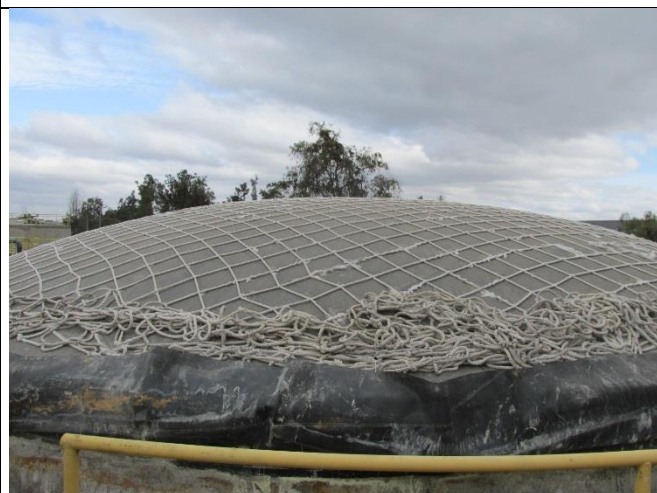
Fotografía 7. Geomembrana Gas Metano
