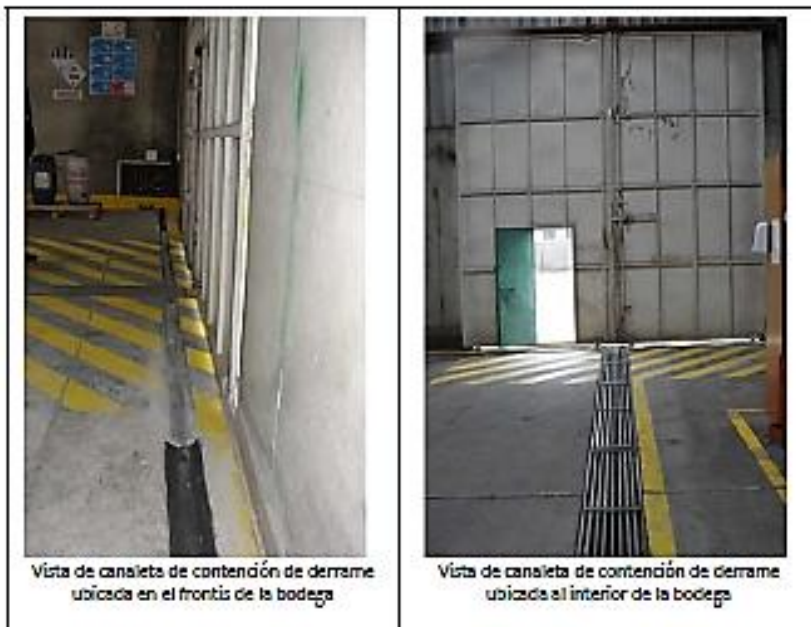
Imagen 7: Canaletas de contención de derrames
