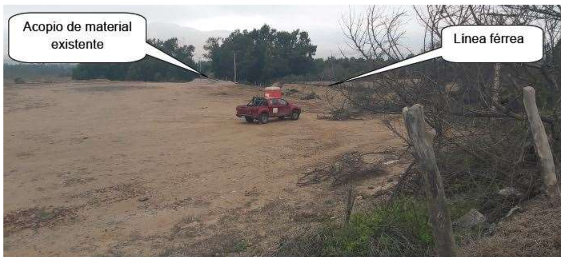
Camioneta y baño químico no pertenecientes a la constructora.
