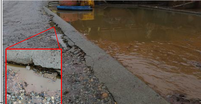
Fotografía N°20 | Fecha: 11-08-2020 Descripción del medio de prueba: Área de contención de Riles a un costado de máquinas lavadoras, se observa colmatada y con escurrimiento hacia el camino de ripio, por deterioro del pretil.
