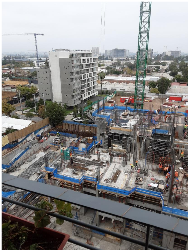
Figura 1. Vistas construcción desde piso 10
