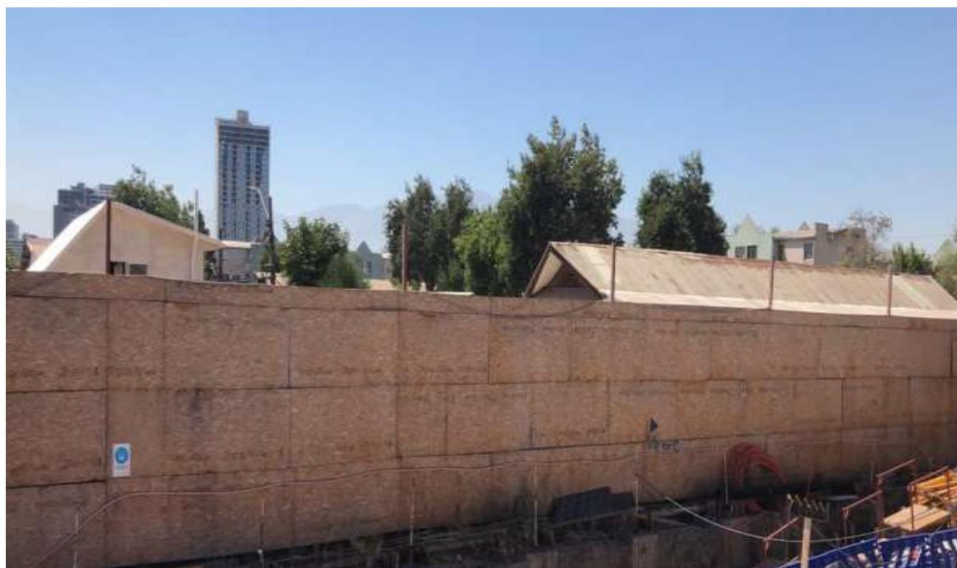
Figura 4. Cierre acústico perimetral existente, tipo "sándwich" con el relleno fonoabsorbente entre ambas planchas de OSB. – Fuente: Entregado por el titular.
