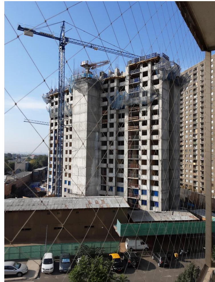
Figura 8. Vista tomada de una inspección en terreno. – Fecha: 02/03/2021
