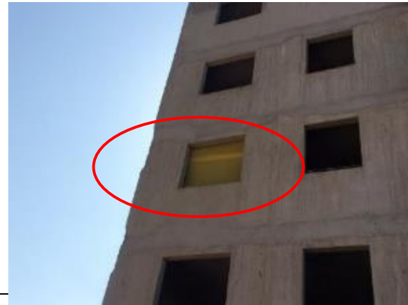
Figura 6. Fecha: 04-03-2021 Coordenadas DATUM WGS84 HUSO 19 Norte: 6.302.472m Este: 340.862m Descripción del medio de prueba: Medida acústica implementada en cierre de vanos.
