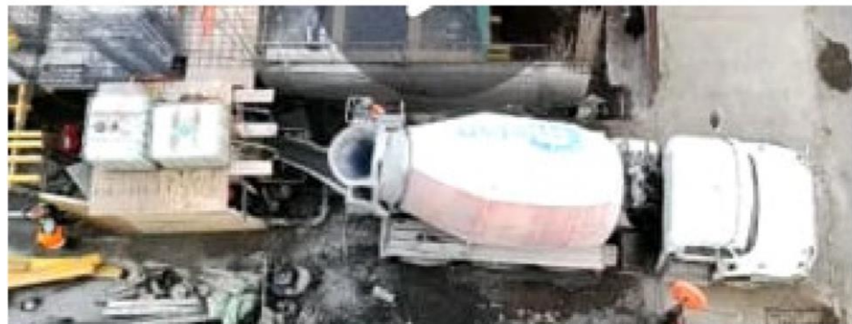
Figura 2. Implementación de barreras para la bomba de hormigonado.
