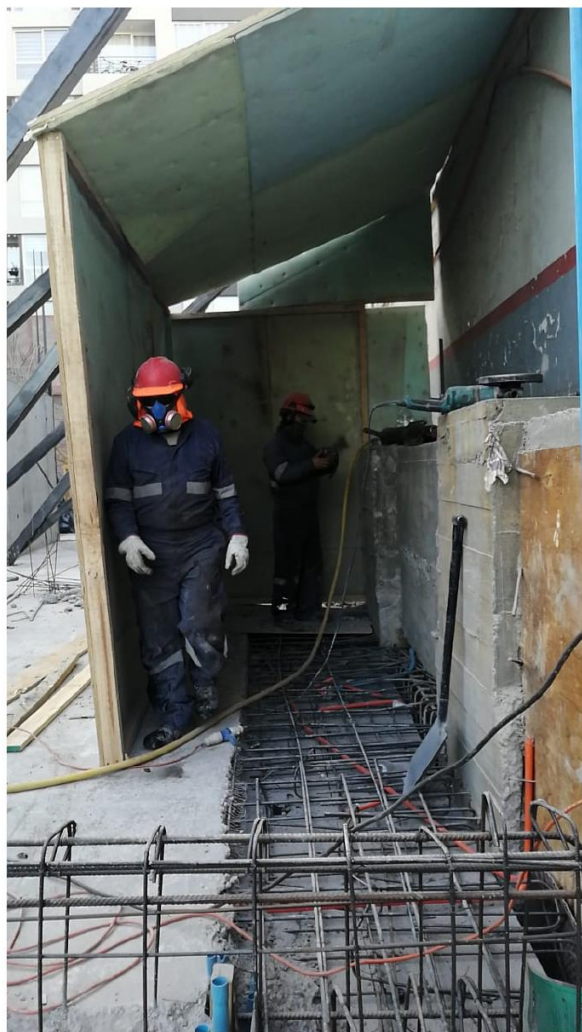
Figura 1. Implementación de barreras acústicas durante la demolición de pilas.
