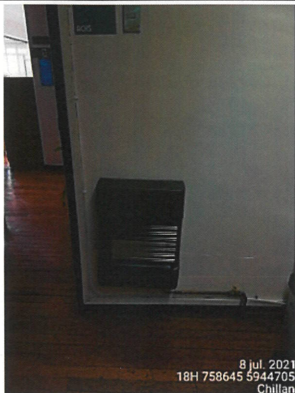
Equipo de calefacción a gas.
